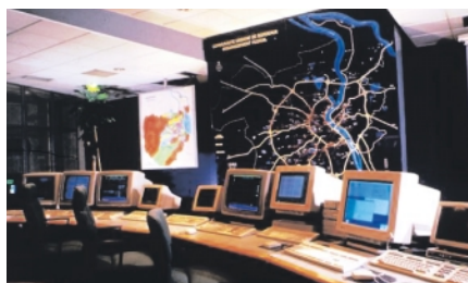
Real-time decision making: the RAMSES flood control centre in Bordeaux (© Suez-Lyonnaise des Eaux et Communauté Urbaine de Bordeaux)
